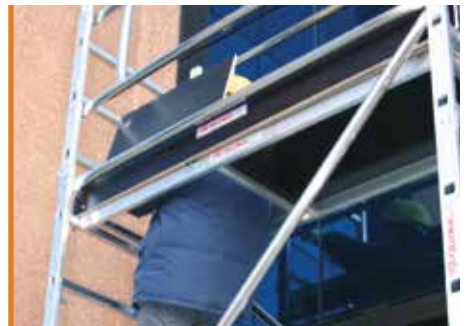
Con l'uso della botola si sale in sicurezza. Use the trapdoor to go up safer.
