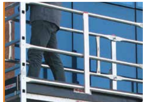
Rinforzo per parapetto. Reinforce for railing.
